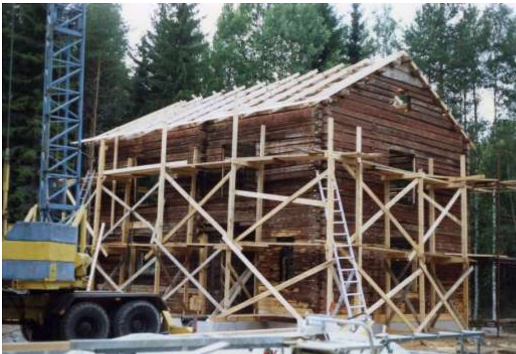
Att bygga upp huset, foto Gun Skoglund, Lasse Nygårds
